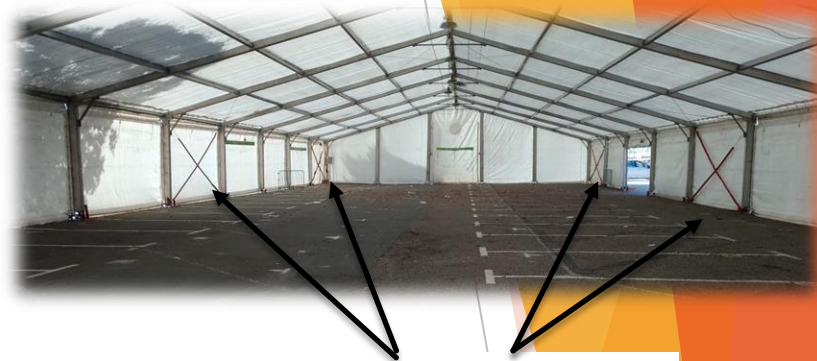
Câbles de contreventement
